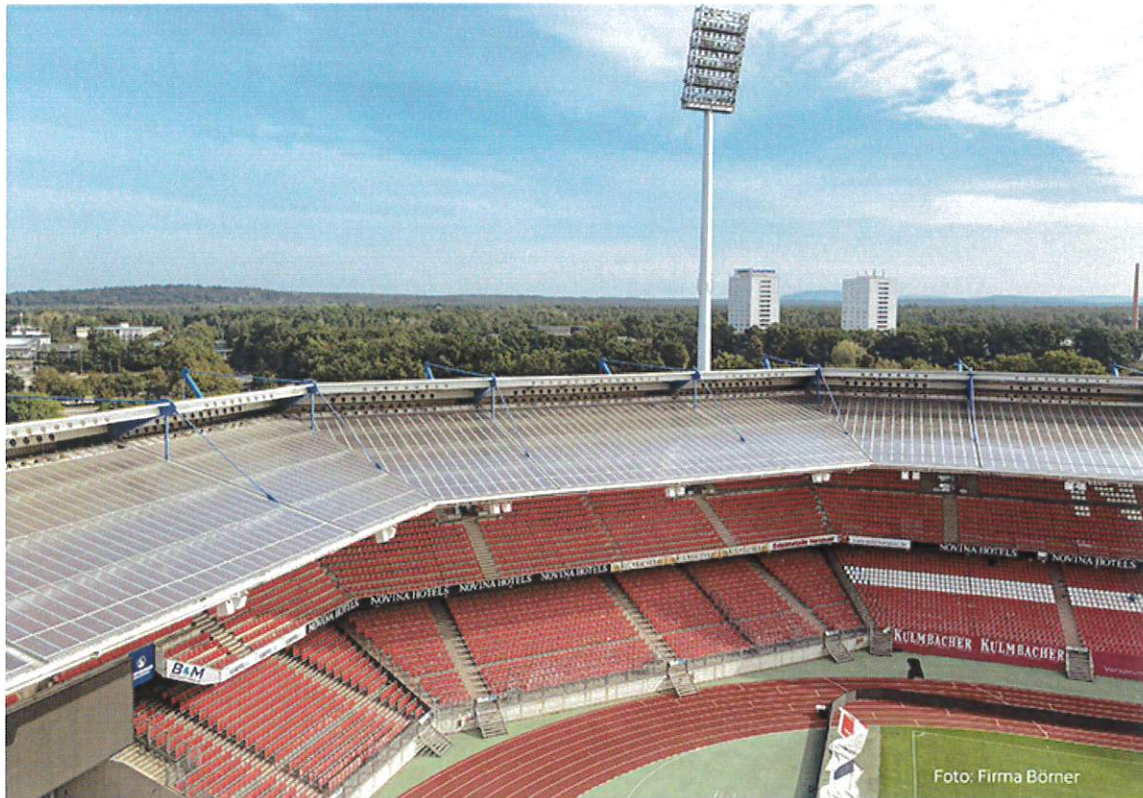
Von Börner-Fachkräften saniertes Stadionsdach in Nürnberg.
